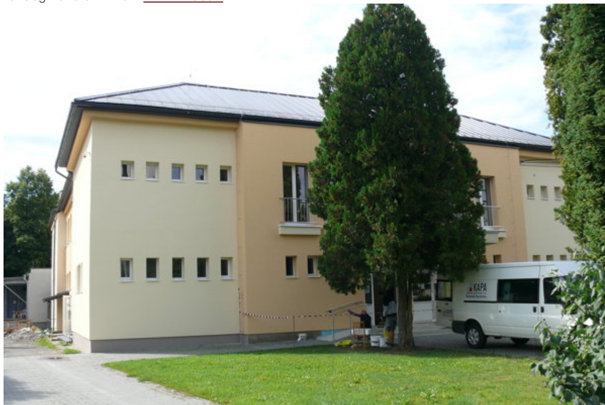
Kultúrny dom v Očovej. (Zdroj: Milan Suja)
